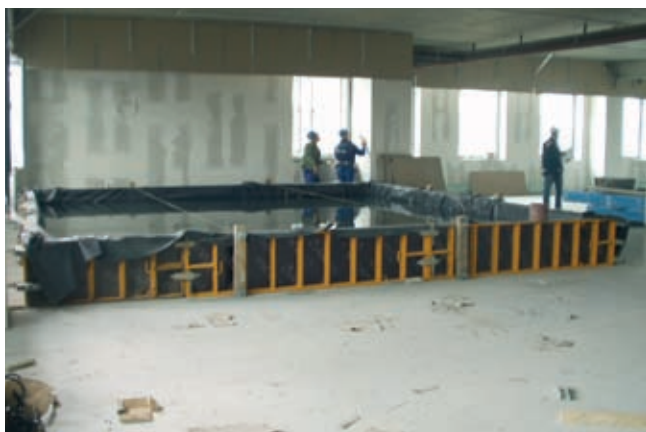
Rys. 3. Obciążenie próbne realizowane za pomocą wody w specjalnym zbiorniku
