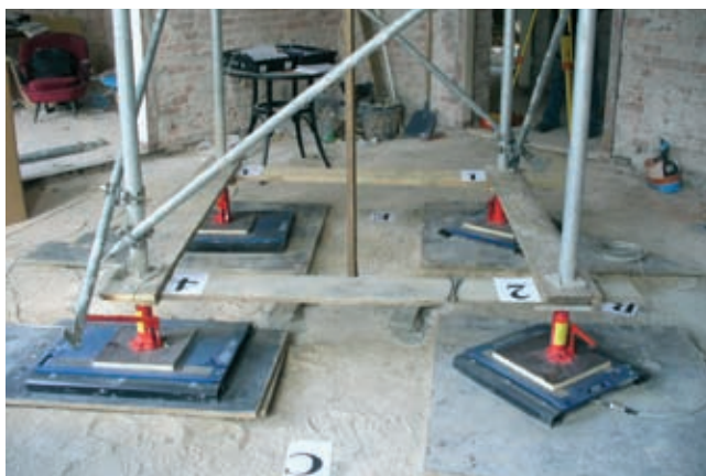
Rys. 4. Obciążenia próbne realizowane za pomocą układu siłowników i podpór szalunkowych
